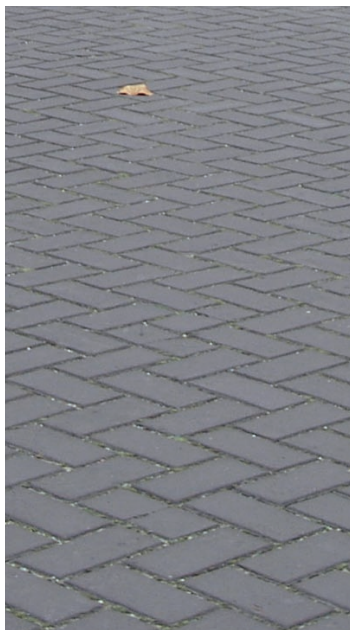
rijweg en trottoir: gebakken klinker Straton 'Mayon'
