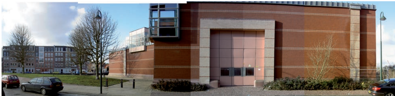
bebouwing aan de noordzijde Verlorenkost: KV-station van Eneco
