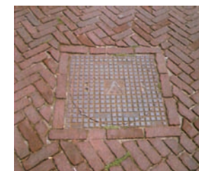
putdeksel - TBS gietijzer
